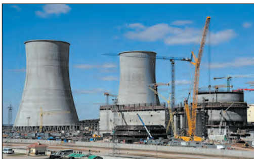
Мал. 1. Будівництво Білоруської атомної електростанції. Згідно з планами перший блок АЕС має бути введений у дію у 2019 р., другий — у 2020 р. Будівництво БелАЕС коштуватиме країні 11 млрд дол.
