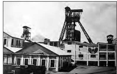
Загальний вигляд відбудованої шахти ім. Ворошилова. Комунарськ (Ворошиловградська обл.). 1946 р.
