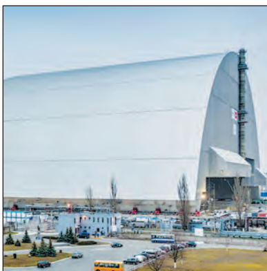
Арка безпеки над 4-м енергоблоком. 2016 р.
