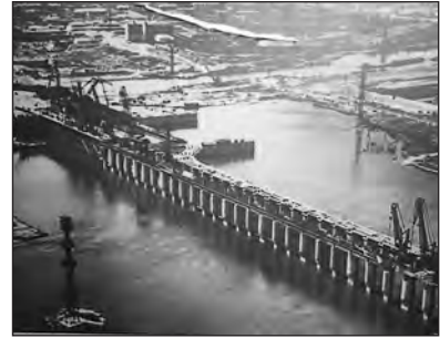
Будівництво Каховської ГЕС. Розпочалося у вересні 1950 р., перший агрегат запрацював у 1956 р.
