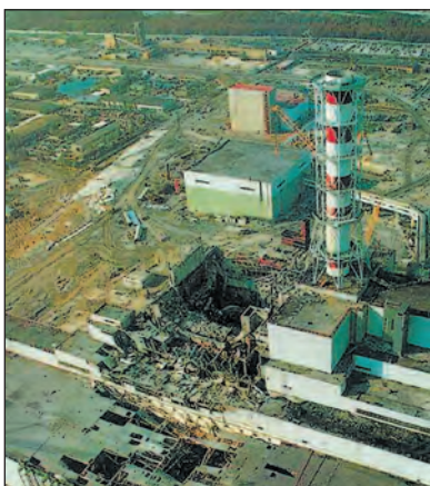
Зруйнований 4-й енергоблок Чорнобильської АЕС. 1986 р.
