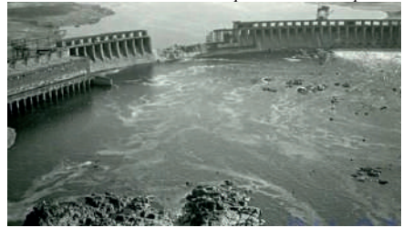
Іл. 32.7. Зруйнована вибухом гребля Дніпрогесу в 1941 р.
