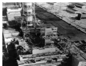
Іл. 32.14. Аварія на Чорнобильській АЕС
