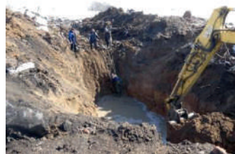
Іл. 33.11. Викопування водовідвідної канави
