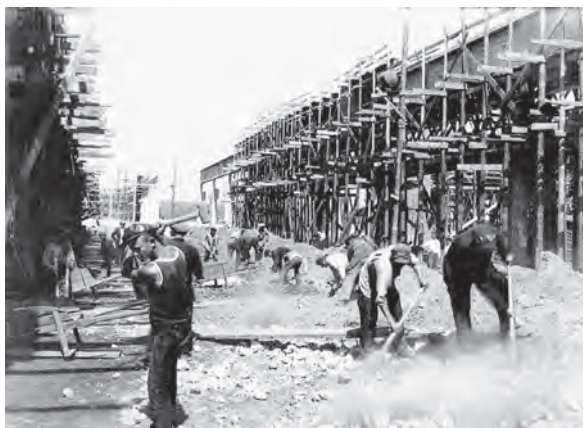
↑ Будівництво механічного цеху № 6 на Новокраматорському машинобудівному заводі. Дніпропетровщина. 1932 р.
