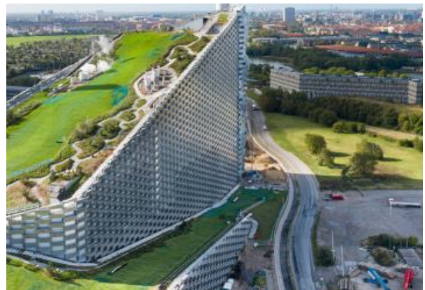
б) «зелені» дахи будинків
