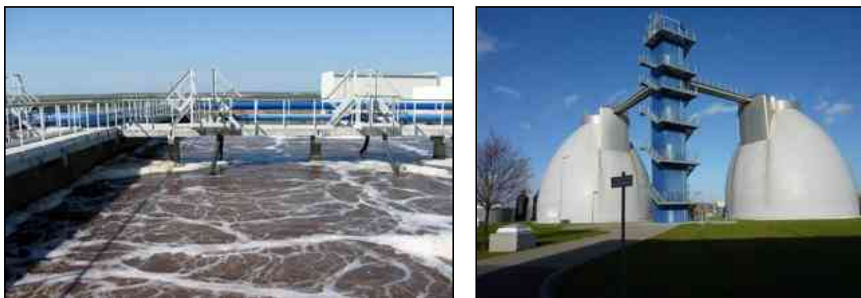
Рис. 64. Аеротенки (ліворуч) і метантенки (праворуч)
