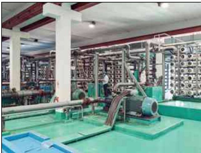
Рис. 56. Електричні насоси і мембранні трубки зворотного осмосу на опріснювальній установці, Саудівська Аравія
