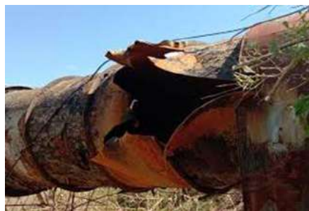
Рис. 9.11. Пошкодження артобстрілами ділянок трубопроводу каналу Сіверський Донець – Донбас призвело до припинення водопостачання населених пунктів Донбасу на кілька тижнів (2014-2021 рр.) [13]
